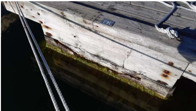
Det är Norrköpings kommuns skrotade flytbrygga från Beckmansviken i Arkösund som sedan årtal ligger vid Bergön och läcker frigolit ut i sjön. Den skyddande betongen
