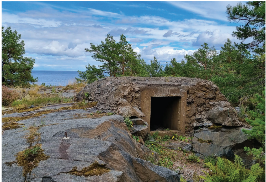
Figur 5. Foto på en av de militära lämningarna, ett av öns många stävärn med utsprängd skyttegrav. Denna är en av de mer välbevarade, många andra är igenfyllda med sprängsten. Foto Sweco, 2022.
